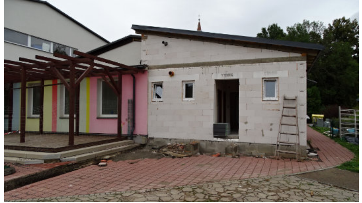
Přístavba toalet k jídelně
