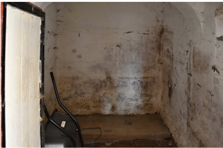
Technická místnost v obytné budově – budoucí toalety
