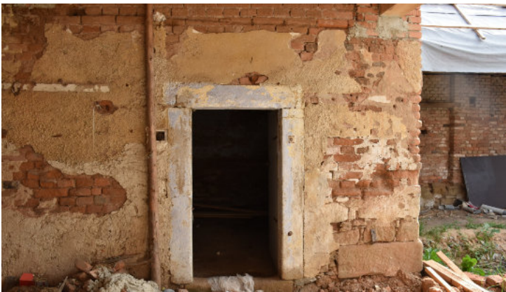
Dvorek – bývalé chlévy, budoucí kuchyňka a společenská místnost
