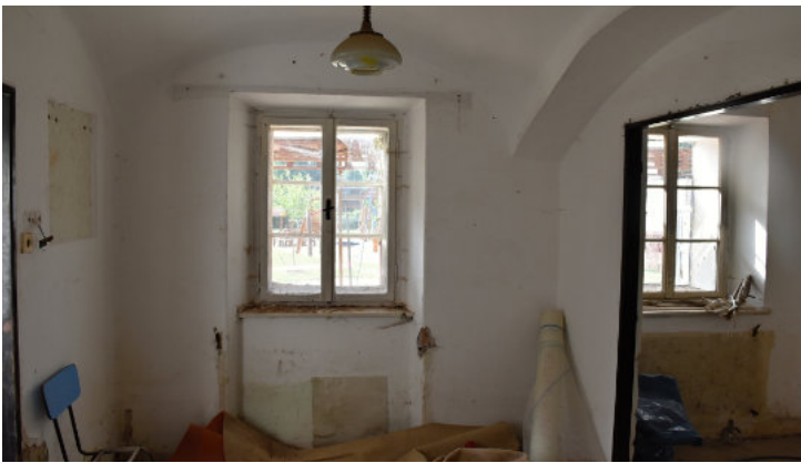
Místnost v obytné části směrem k východu – budoucí knihovna
