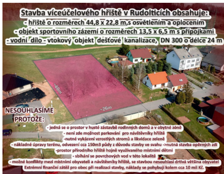
Obrázek: Stavba víceúčelového hřiště v Rudolticích
