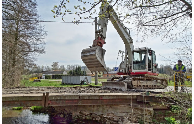
Oprava mostu za Konzumem
