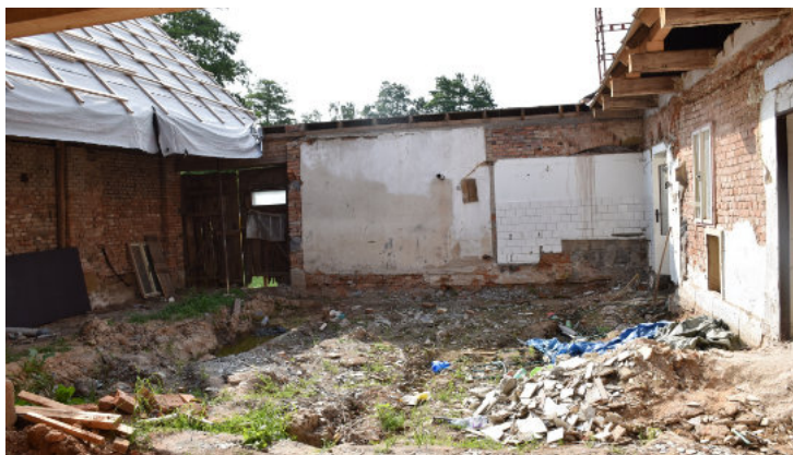
Dvorek – pohled na jižní stěnu k dětskému hřišti
