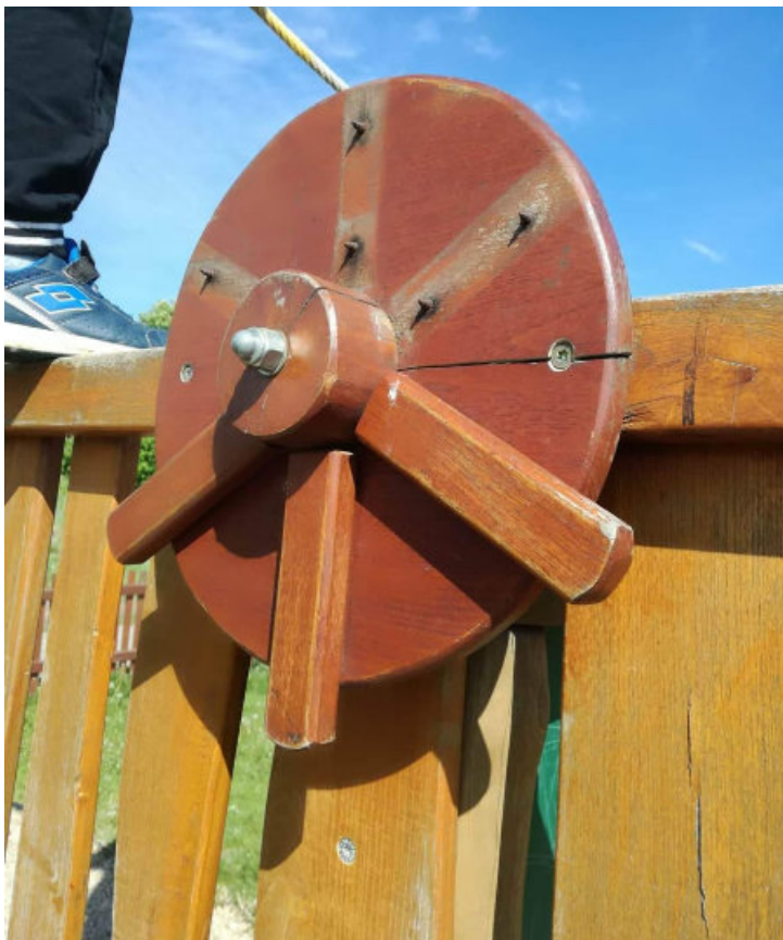
Chybějící dřevěné části atrakcí
