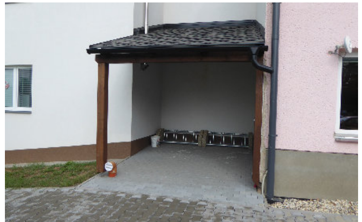
Stojany na kola u budovy základní školy
