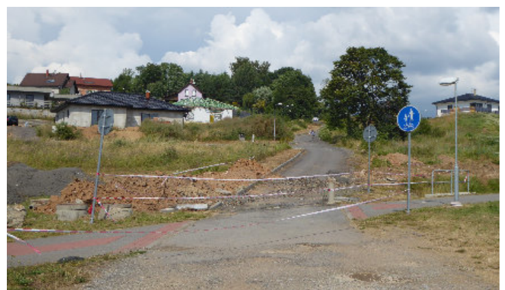
Oprava kanalizace na Zámčoku
