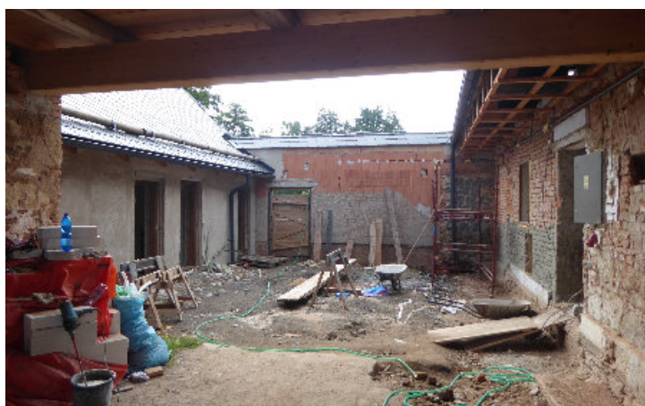
Dvůr budovy č. p. 5 – vlevo budoucí veřejné toalety
