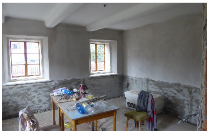
Interiér v budově č. p. 5 – druhá místnost budoucí knihovny
