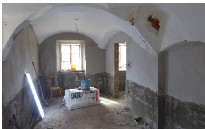
Interiér v budově č. p. 5 – první místnost budoucí knihovny
