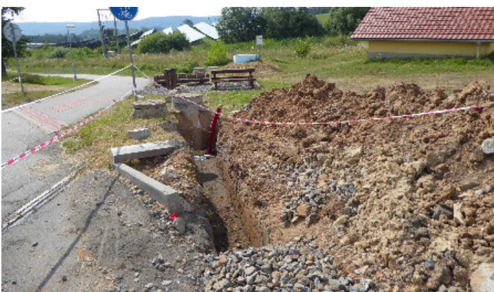
Oprava kanalizace na Zámčoku
