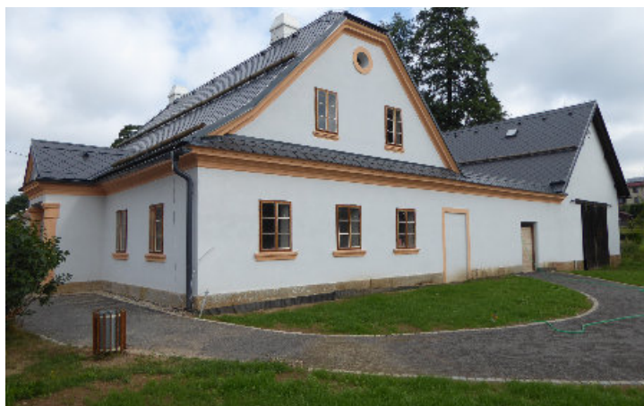
Rekonstrukce exteriéru budovy č. p. 5 je dokončena
