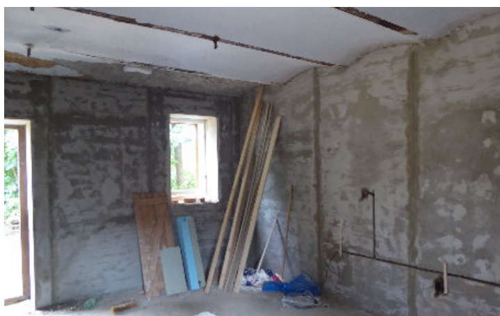
Dvůr budovy č. p. 5 - budoucí kuchyň ke společenské místnosti
