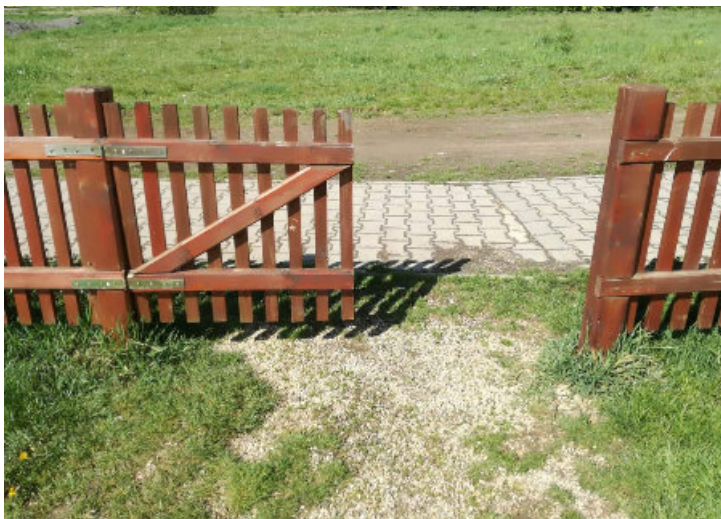
Chybějící křídlo branky
