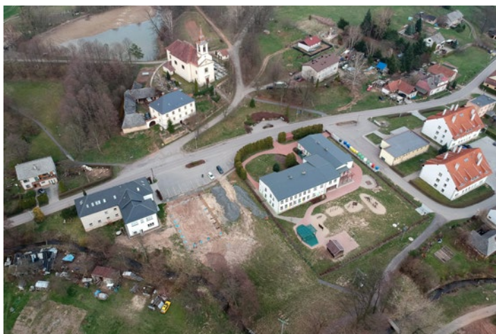
Budované školní hřiště
